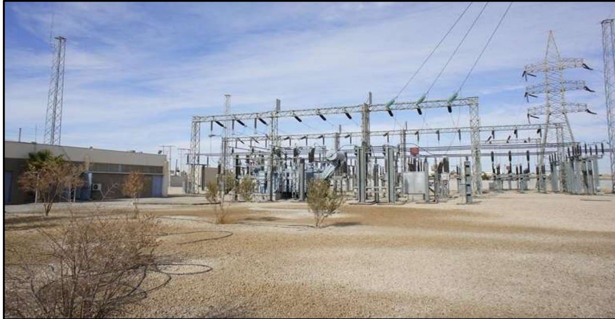
الشكل 9: محطة فرعية نموذجية بجهد 220/33 كيلوفولت
